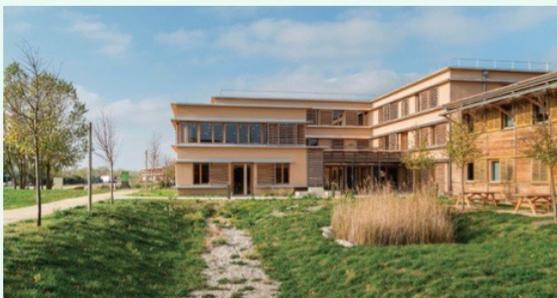
La [construction du siège social de la Communauté de Communes du Val de Drôme](#) est la référence de la solution sur la filière paille. Il associe des murs bois préfabriqués, une isolation par bottes de paille et une structure de poteaux/poutres et dalles en béton. Il a été inauguré en 2019 et **l'ensemble du bâtiment est à énergie positive**.
